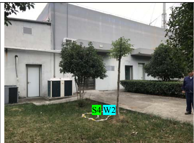
污水站西侧：S4、W2
